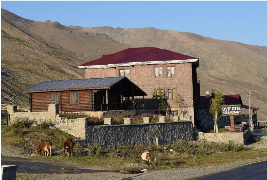
Fotoğraf 9. Ovit Yaylası'ndaki konaklama tesisinden bir görünüm.
